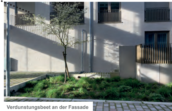
Verdunungsbeet an der Fassade
